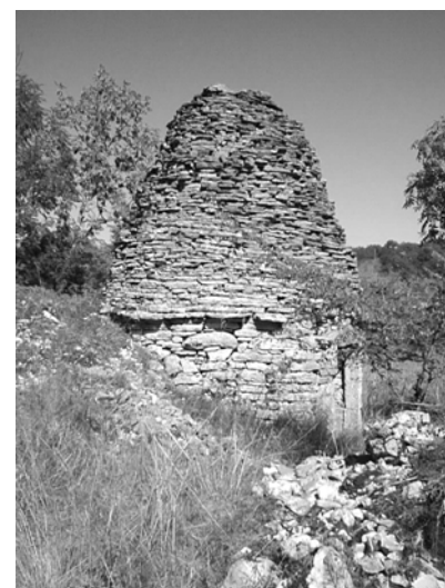
Fig.14 : Emploi de la "pierre de Crayssac" pour la construction traditionnelle des cazelles.
